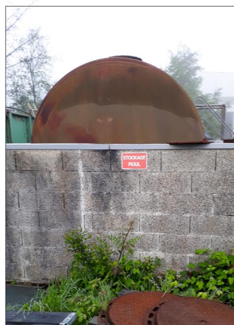
Cuve de carburant sur rétention
