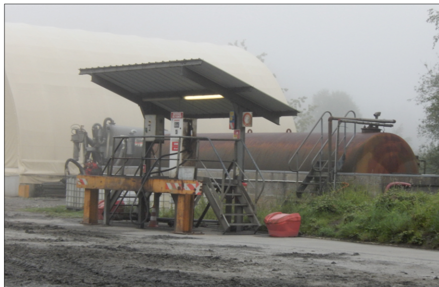
Ravitaillement sur aire étanche
